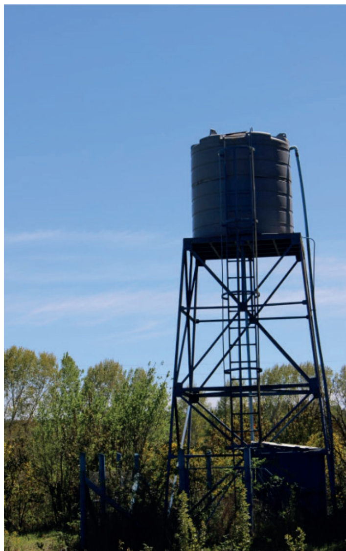
Infraestructura APR San Antonio
