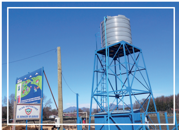
Obra APR Cullinco
