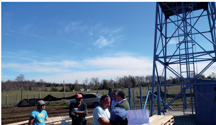
Revisión de obra, Cullinco
